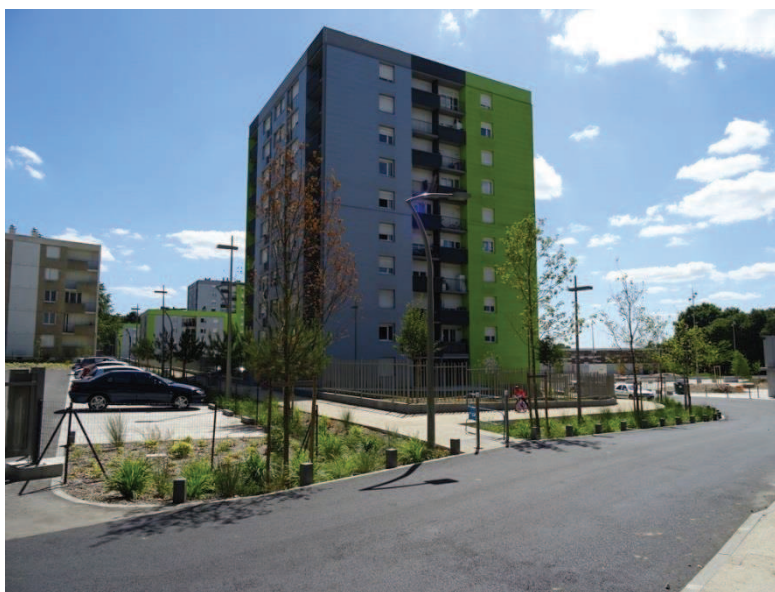
Résidentialisation en cours de finition sur le secteur Franchet d'Esperey
